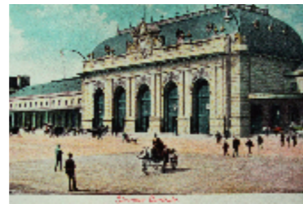
Milano, vecchio edificio della Stazione centrale, (sec. XIX). Facciata e paramenti interni in pietra di Viggù
