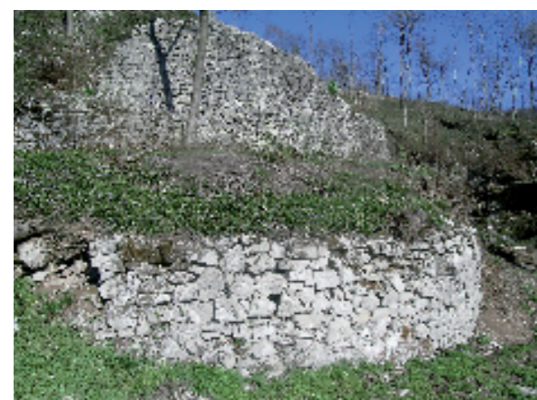
Un muretto di pietra a secco realizzato con il materiale di scarto delle cave
