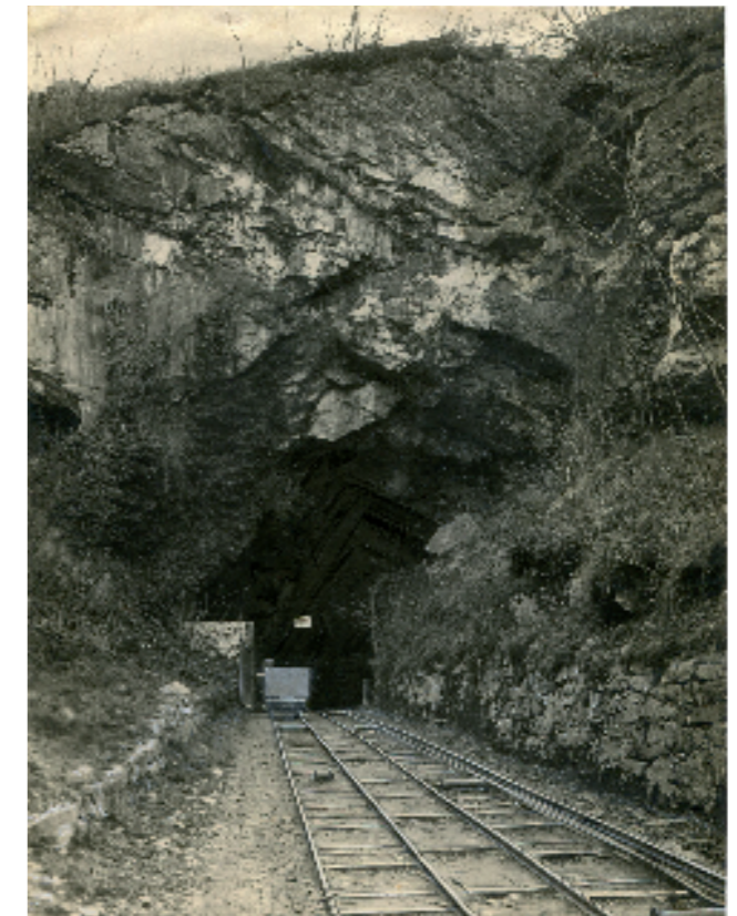
Viggiù, Piamò Superiore: imbocco della Cava Malnati con i binari usati per il trasporto delle pietre ai laboratori.
